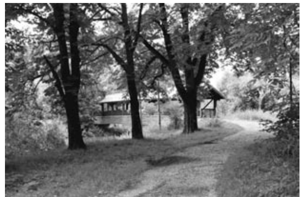
FFH-Gebiet Leipziger Auensystem, bei Schkeuditz, Landkreis Delitzsch, Sachsen Ansprüche von Erholung und Naturschutz in der Nähe der Großstadt Leipzig müssen koordiniert werden. Die vollständig aus Holz gefertigte Hausbrücke über die Weiße Elster passt sich in das Landschaftsbild ein und ist zugleich ein touristisches Kleinod. Foto: Jens Schiller.
