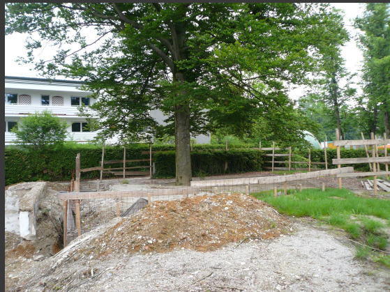
Buche vor Baubeginn (August ) (Bauschutzzaun und Wurzelvorhang bereits ein Jahr vor Baubeginn
