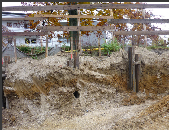
Baugrube 1m tief (September)
