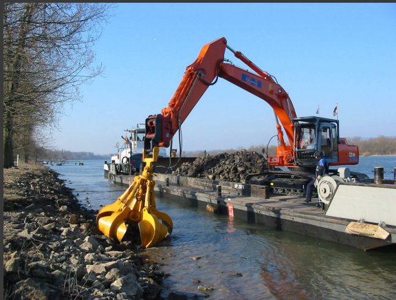
UBB bei Wasserbauarbeiten
